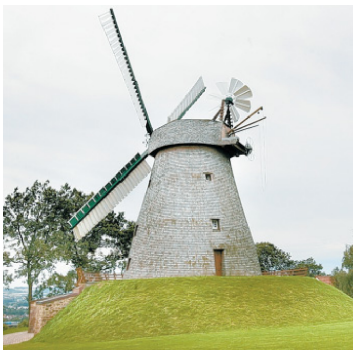
Hier lässt sich gut feiern: Die Windmühle auf der Steinegge in Exter ist wieder betriebsbereit.
