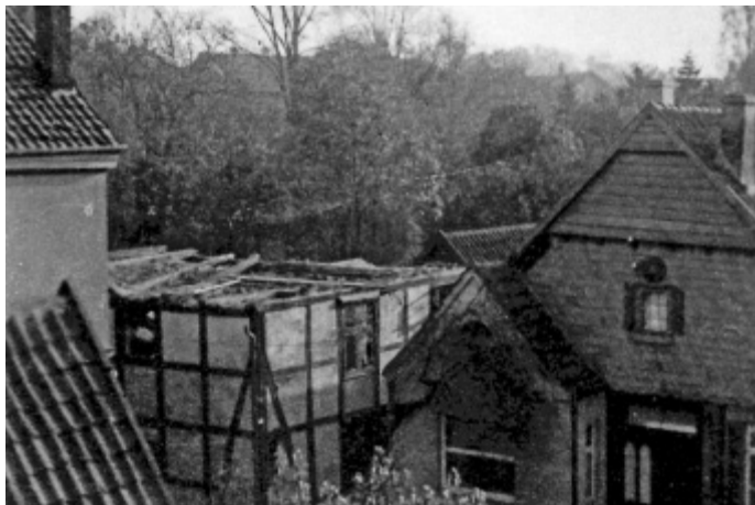
Zerstört: Von der Synagoge in Bünde stehen nur noch die Grundmauern. FOTO: ARCHIV MILITZER, SAMMLUNG TAPPER/SCHROER
