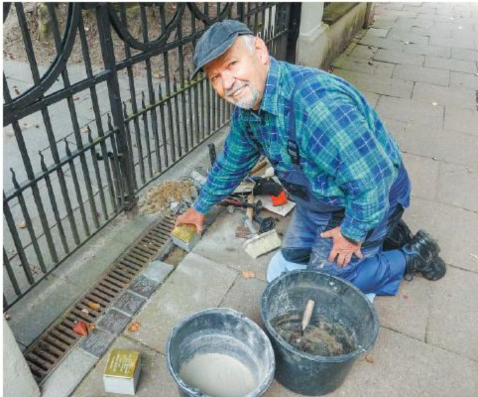
Erinnerung an die Ermordung jüdischer Herforder: An ihrem letzten Wohnort, am Lübbertorwall 18, verlegt Friedel Böhm die neuen Stolpersteine für Albert und Johanna Schiff.
